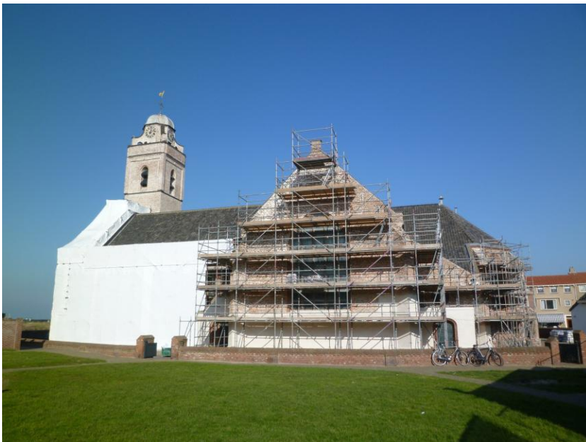
afb. 2 Het aanbrengen van de kaleilaag (24 oktober 2011)
