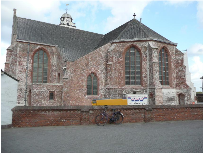
afb. 1 Het verwijderen van alle verflagen (21 augustus 2009)
