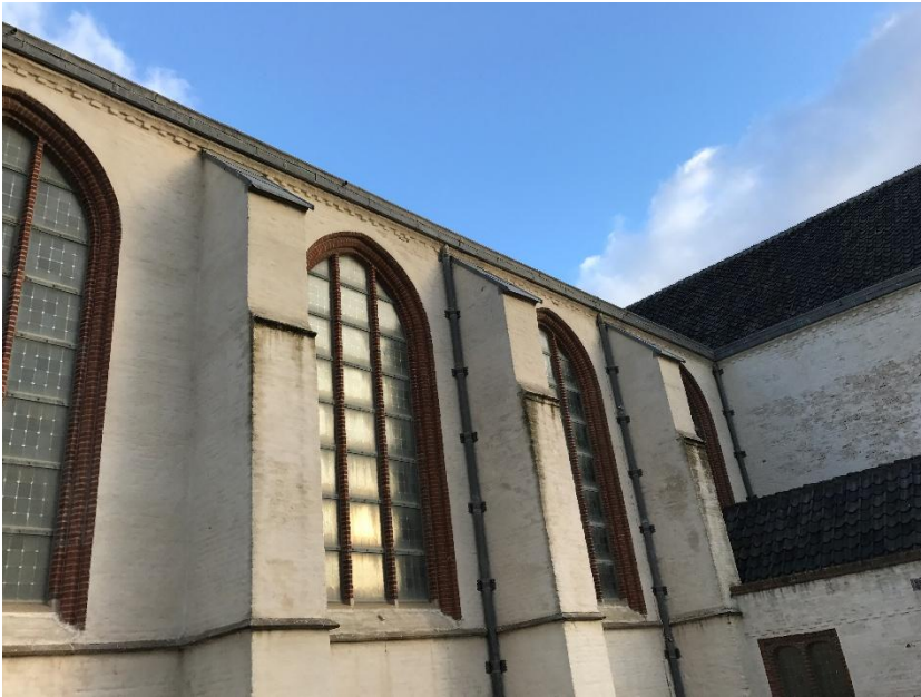
afb. 4 Steunberen met afdekking op de hoge delen
