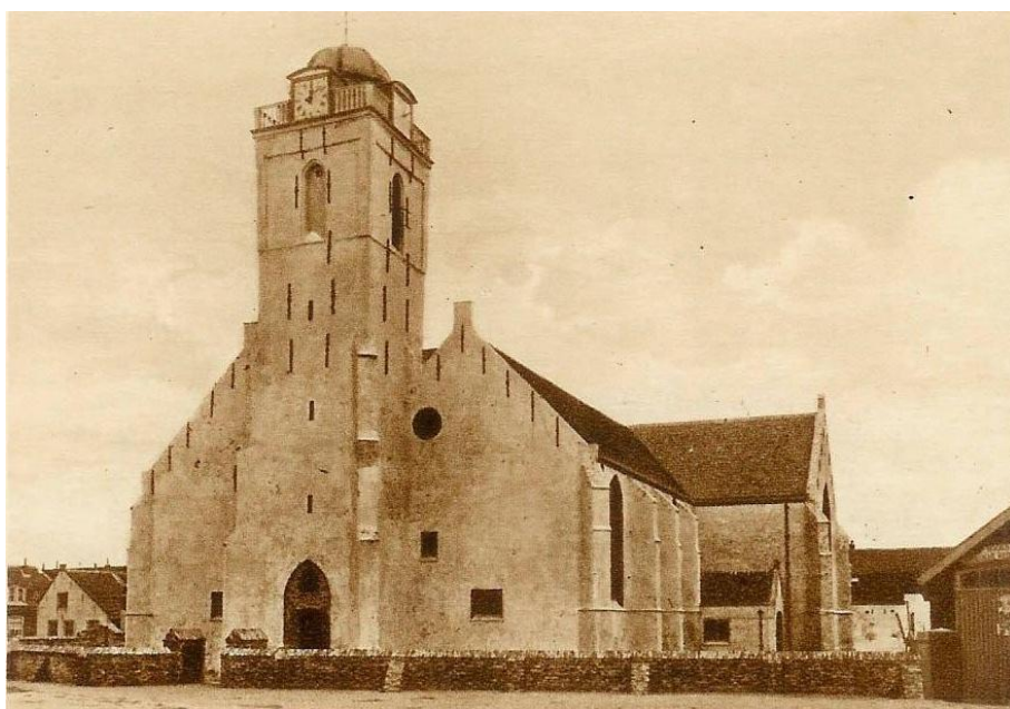
afb. 8 Oude Kerk ca. 1930 na restauratie en herbouw transept en koor
